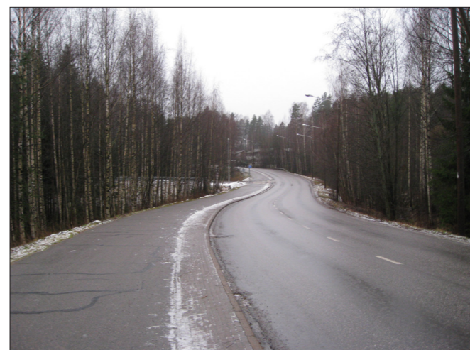
Betonipäällysteinen erotuskaista Palttinatiellä.
