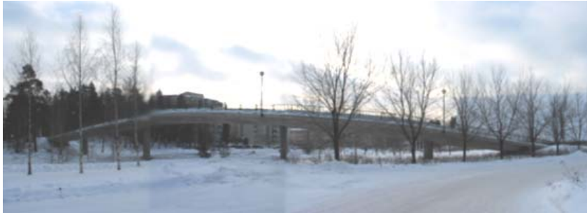
Kuva 121. Sillan 1515 valaistuksen nykytilanne.
