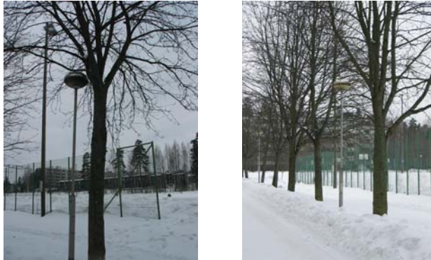
Kuva 35. Oksistot peittävät paikoin raittien valaistusta, esimerkkejä Suvantopolulta (3/2005).
