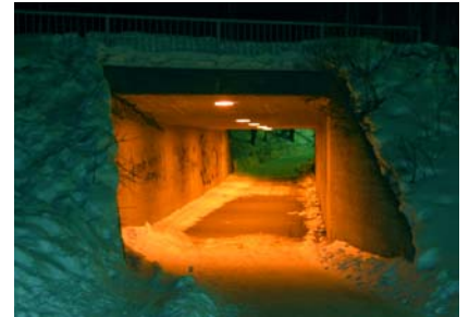
Raappavuorentien alikäytävä (nro. 1513)
