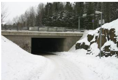
Louhelantien putkisilta (nro. 1603)
