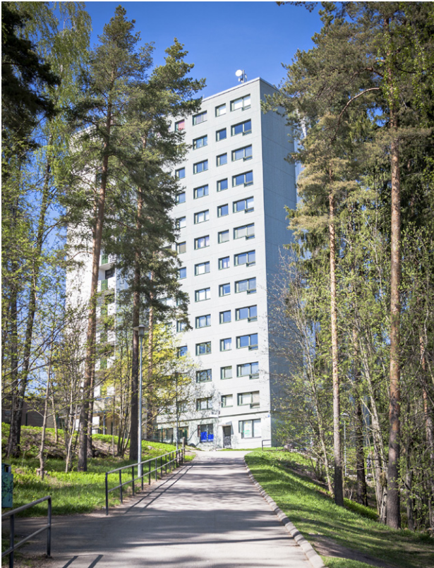
Kuva 15. Havukoski on 70-luvun lähiö, jonka valaistus tulisi uusia kokonaisuutena. Kuva Vantaan kaupunki.
