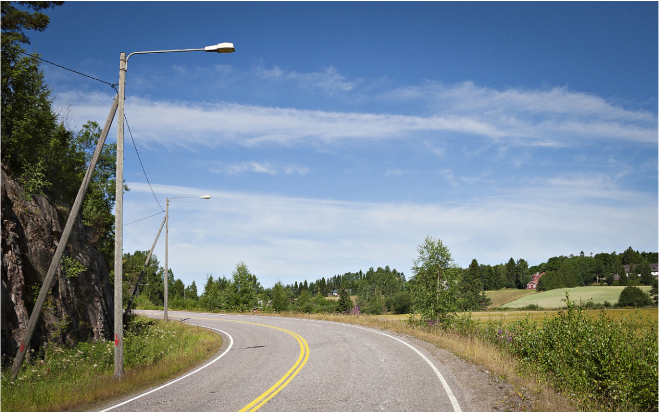
Kuva 17. Keimolan peltomaisemaa. Monissa paikoissa Vantaalla on vielä käytössä puiset valaisinpylväät ilmajohtoineen. Kuva Vantaan kaupunki.
