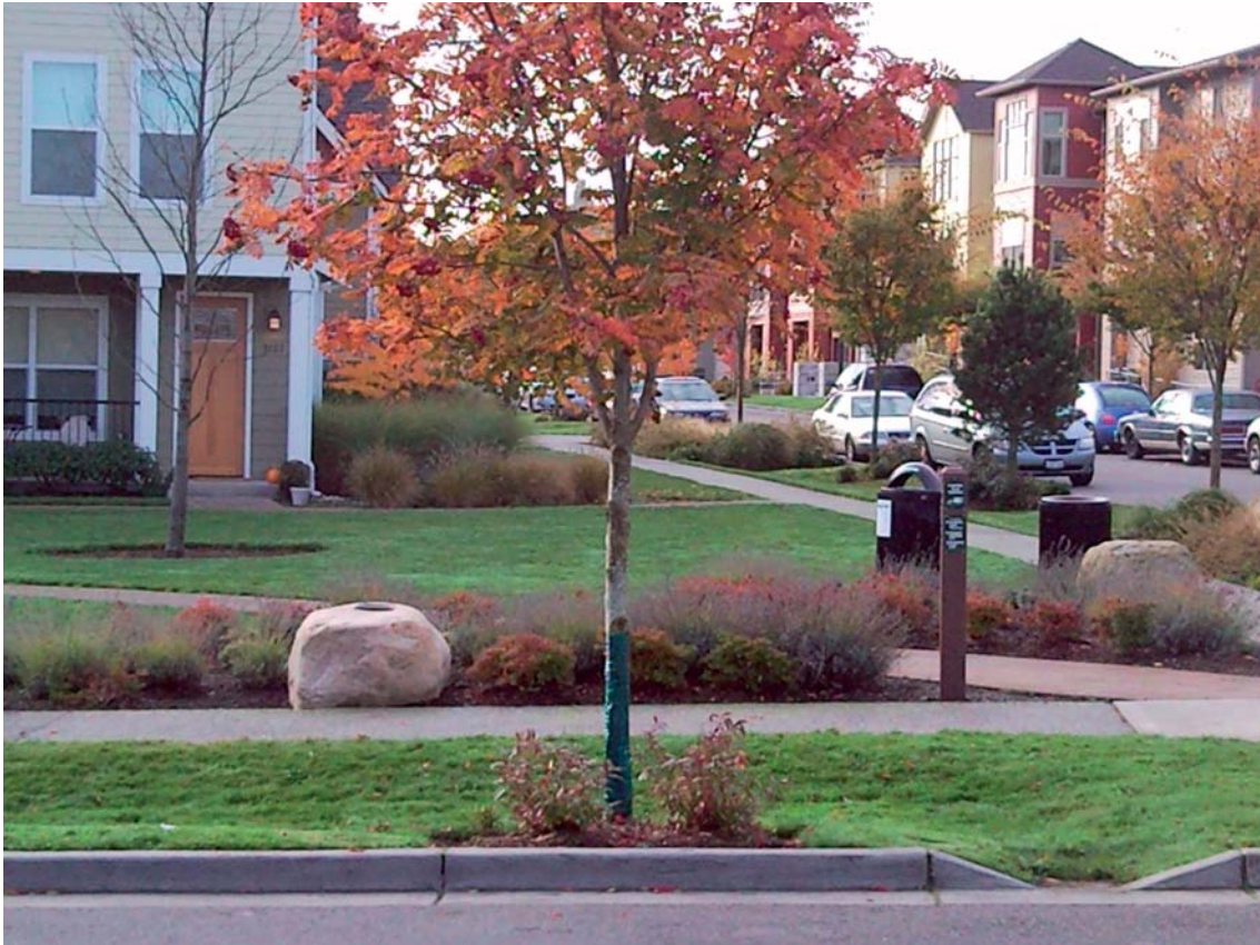
Kuva 39. Imeyttävät ja pidättävät painanteet, painanne tonttikadun varressa. Reunakiveen on tehty aukko hulevesiä varten. (kuva Topi Tiihonen, High Point, Seattle)
