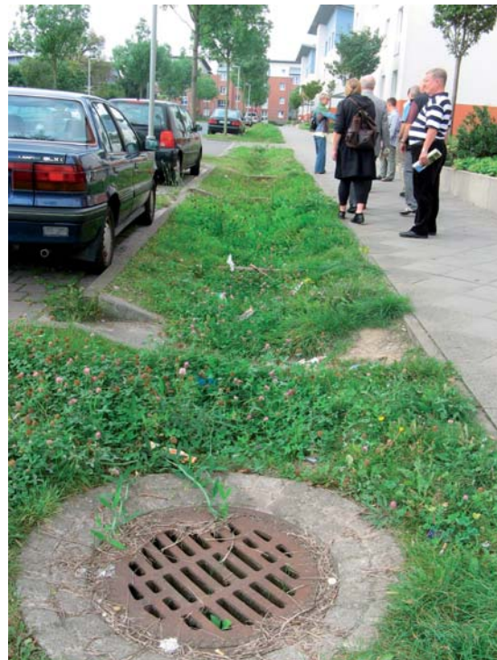
Kuvat 31-33. Hulevesiä johtavat ja pidättävät nurmiverhoillut painanteet Hannoverista, Saksasta. (kuvat: Pirjo Siren)
