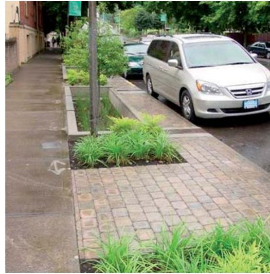
Kuvat 34-35. Imeyttävät ja pidättävät painanteet. Yllä vasemmalla ennen painanteiden asettamista katualueelle ja yllä oikealla sama katualue luonnonmukaisella painanteella Portlandissa. (kuvat: Topi Tiihonen)
