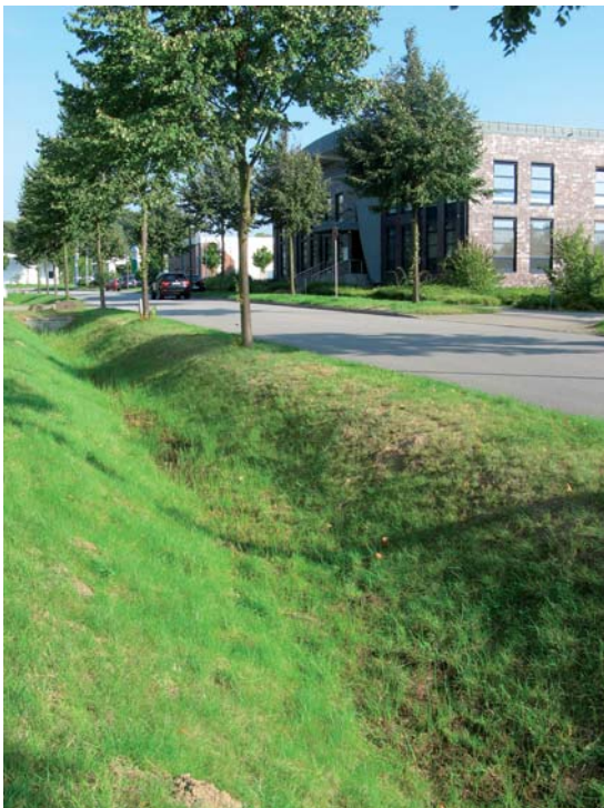
Kuvat 31-33. Hulevesiä johtavat ja pidättävät nurmiverhoillut painanteet Hannoverista, Saksasta. (kuvat: Pirjo Siren)
