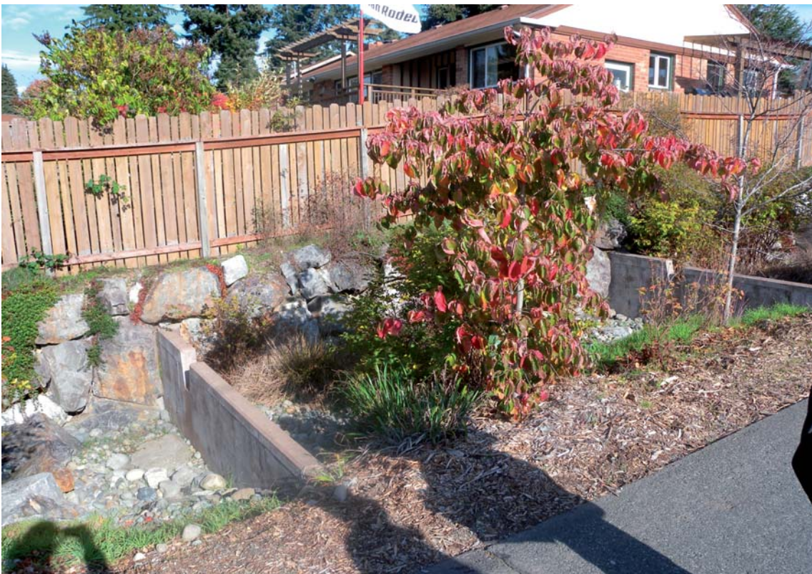
Kuva 36. Imeyttävä ja pidättävä painanne tonttikadun varressa Portlandissa. Tarkistuspadot pidättävät ja hidastavat hulevesiä ehkäisten eroosiota, ja varmistavat hulevesien hallitun etenemisen kohti vastaanottavaa vesistöä. (kuva: Topi Tiihonen)
